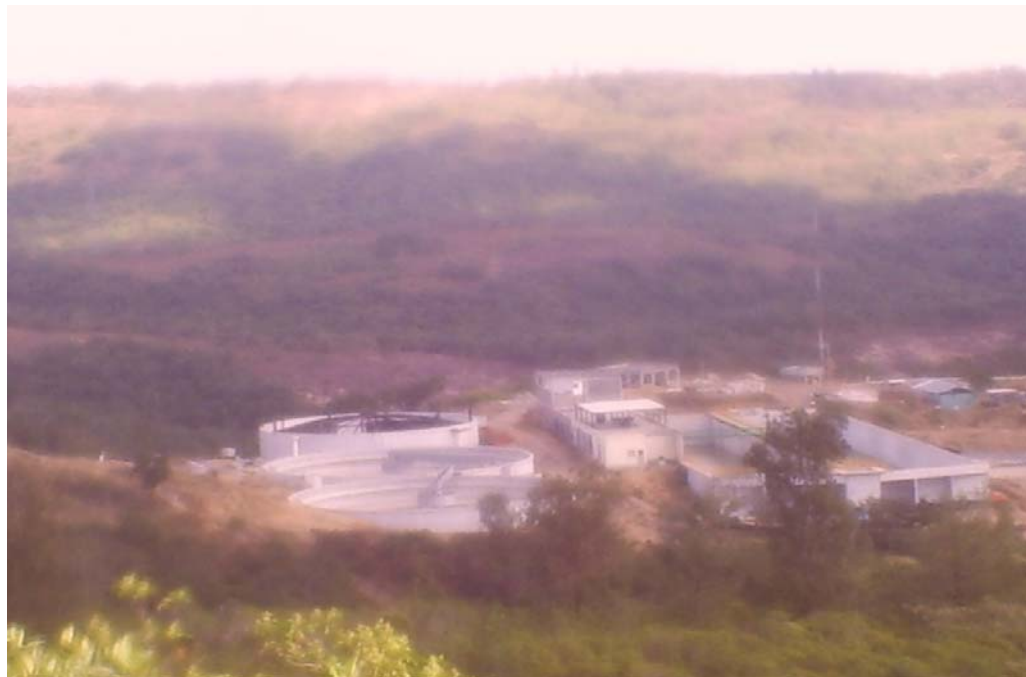
Planta de Tratamiento de Aguas Residuales en Construcción
